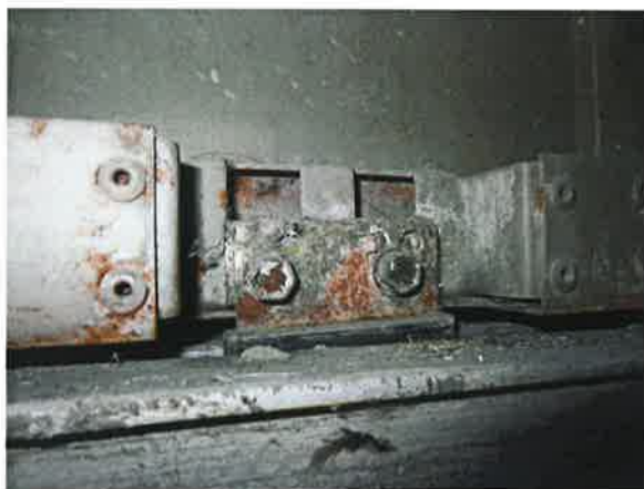
图 13：层门门滑块锈蚀明显
