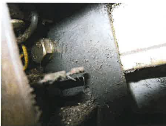
图 15：层门门锁电气开关触点氧化
