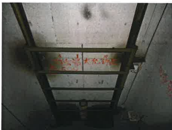
图 17：底坑对重运动区域防护不符合现行标准
