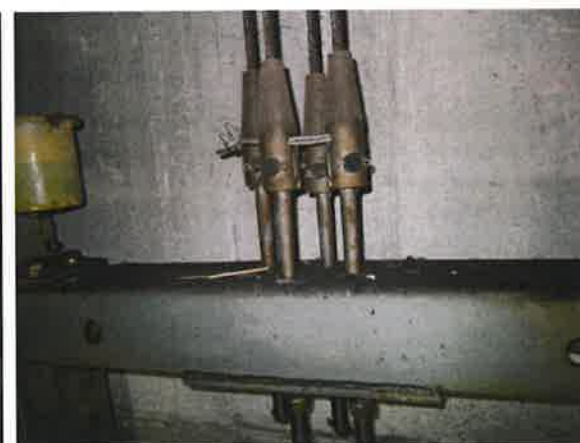
图 12: 绳头组合无弹簧缓冲装置
