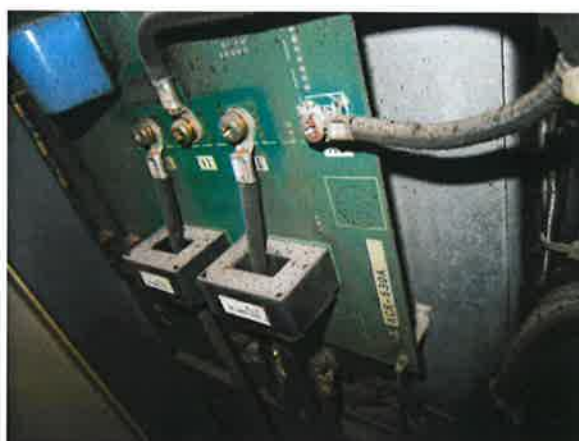
图 4: 调速装置的功率器件老化
