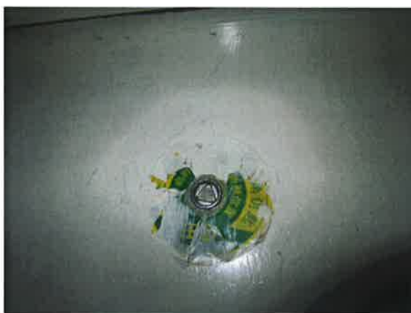
图 14：层门紧急开锁警示标识指示不清晰
