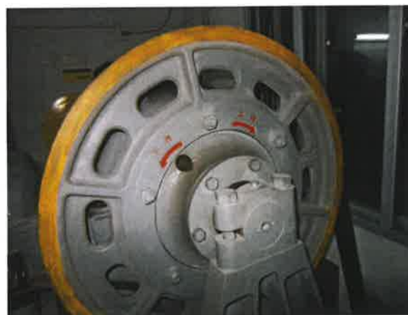
图 11: 曳引轮未设置防止异物进入的防护装置
