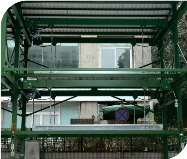
快易停载车板直接放在横梁上
