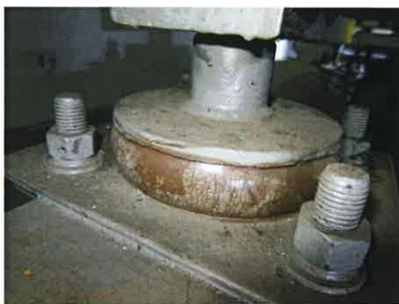
图 16: 主机减震胶老化变形
