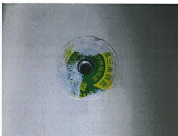
图 18: 层门紧急开锁警示标识指示不清晰
