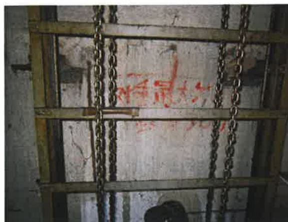
图 23：底坑对重运动区域防护不符合现行标准
