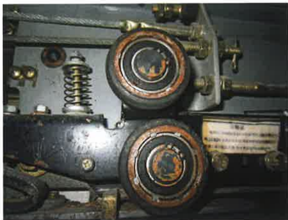
图 19：层门锁紧装置门滚轮锈蚀
