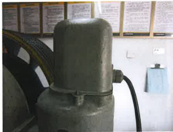
图 11: 制动器仅由一组机械部件（铁芯）组成
