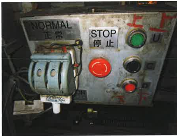
图 9: 轿顶检修和急停开关无防误操作保护
