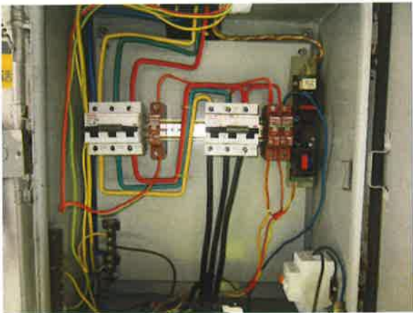
图 8: 主电源开关无防误操作保护
