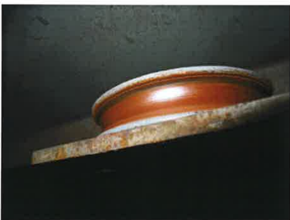
图 17: 轿门门挂轮导向胶老化
