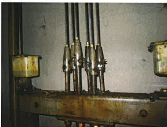
图 15: 绳头组合无弹簧缓冲装置
