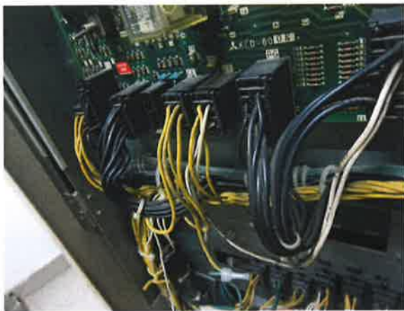
图 7：控制导线及接线端子存在老化及氧化现象
