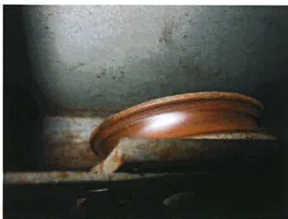
图 16: 轿门门挂轮导向胶老化
