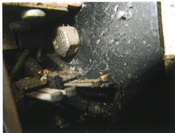
图 20: 层门门锁电气开关触点氧化
