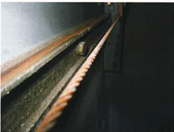
图 17: 层门联动钢丝绳生锈
