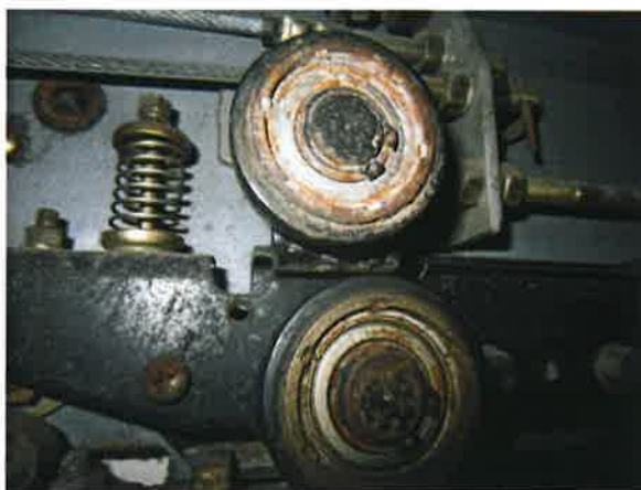
图 18: 层门锁紧装置门滚轮锈蚀
