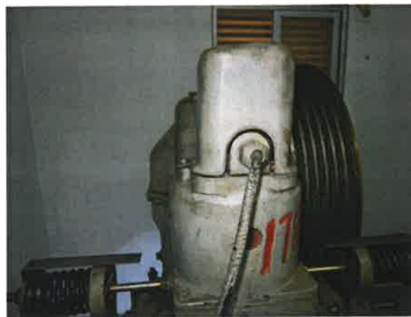
图 11：制动器仅由一组机械部件（铁芯）组成
