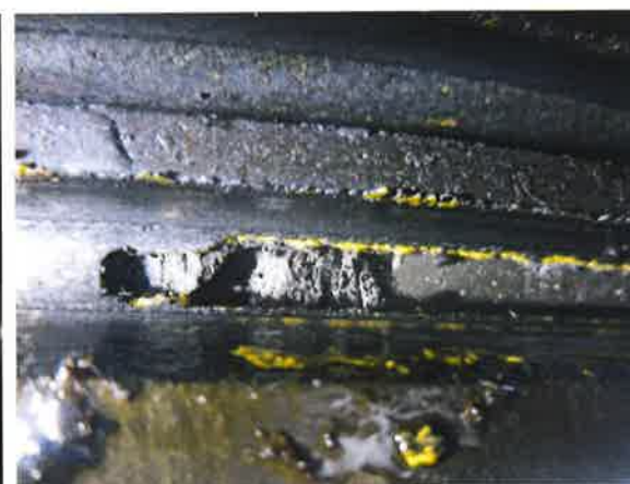
图 12：曳引轮绳槽油泥较多
