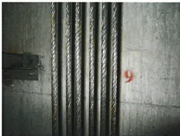
图 13: 曳引钢丝绳有一定程度磨损和金属疲劳
