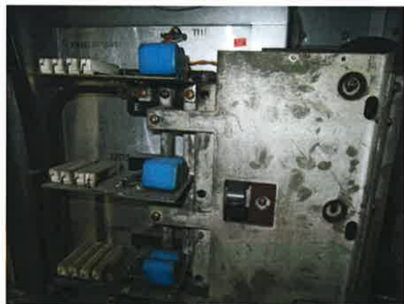
图 4: 调速装置的功率器件老化
