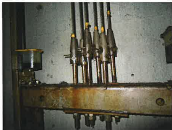
图 14: 绳头组合无弹簧缓冲装置
