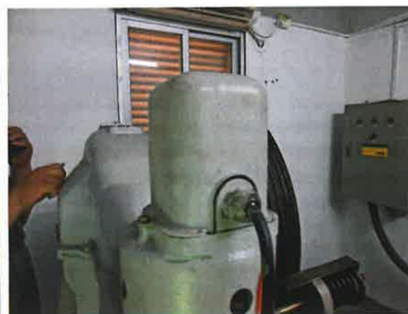
图 10：制动器仅由一组机械部件（铁芯）组成
