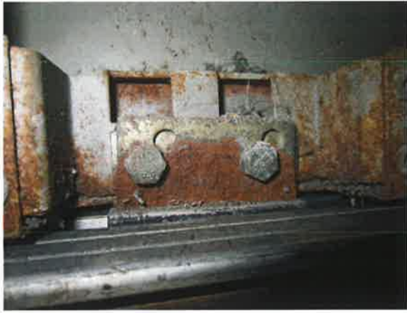
图 19: 层门门滑块生锈
