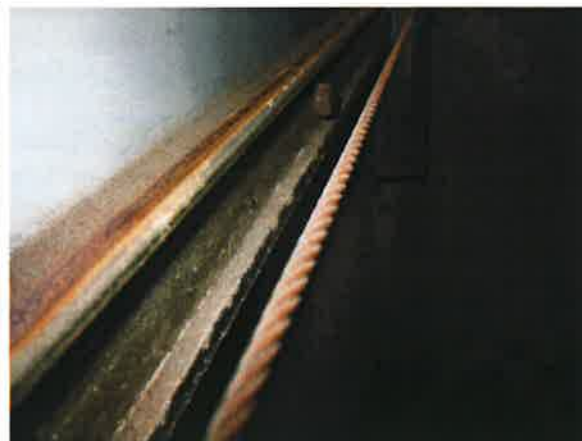
图 16: 层门联动钢丝绳生锈
