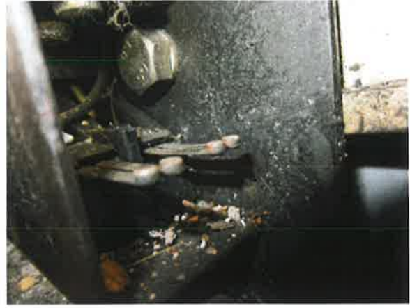
图 20: 层门门锁电气开关触点氧化
