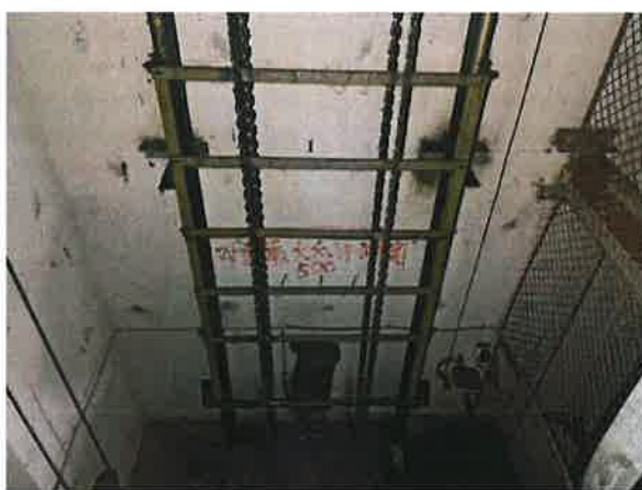
图 17: 底坑对重运动区域防护不符合现行标准
