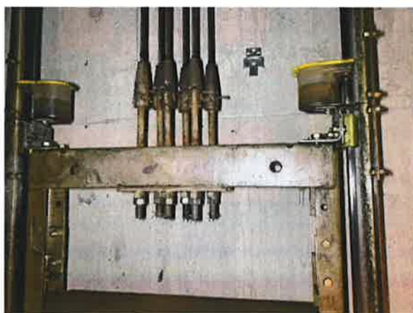
图 15: 绳头组合无弹簧缓冲装置
