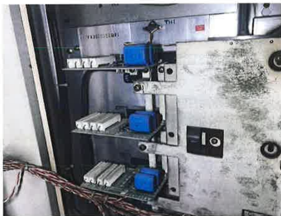
图 8：调速装置的驱动电子板老化
