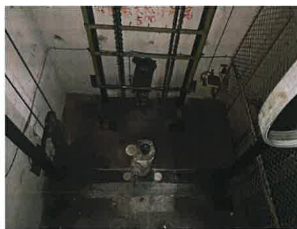
图 18: 张紧轮未设置防异物进入的防护罩
