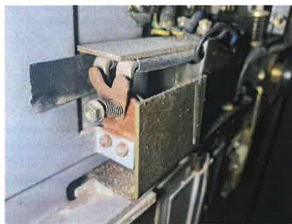
图 16: 层门门锁电气开关触点氧化
