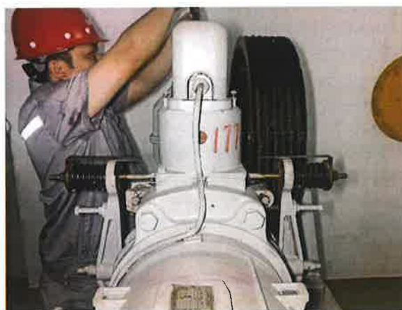
图 10：制动器仅由一组机械部件（铁芯）组成
