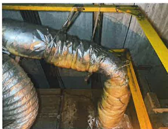
图 14: 轿顶护栏设置不符合现行标准
