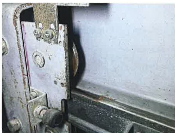
图 13: 轿门门挂轮导向胶老化
