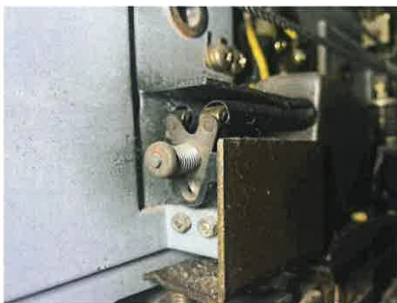
图 14: 层门门锁电气开关触点氧化
