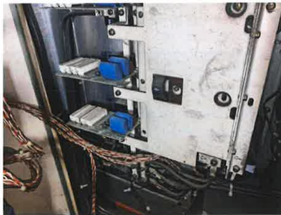
图 9：调速装置的驱动电子板老化
