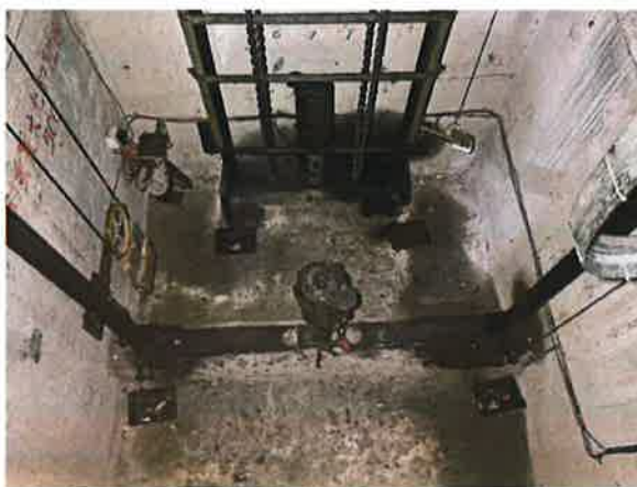
图 16: 张紧轮未设置防异物进入的防护罩
