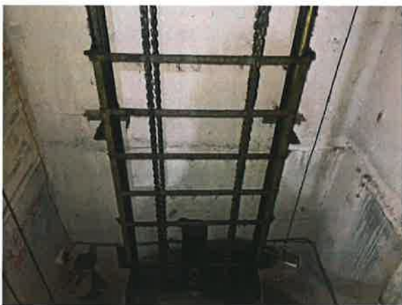
图 15: 底坑对重运动区域防护不符合现行标准
