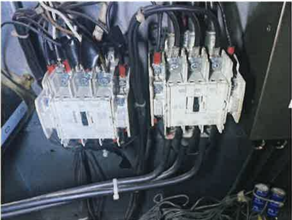
图 6：LB 和 5#接触器已更换为非原装接触器
