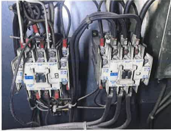
图 7：LB 和 5#接触器触点磨损烧蚀
