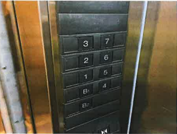
图 3：轿厢部分召唤按钮动作不良
