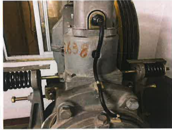
图 10：制动器仅由一组机械部件（铁芯）组成
