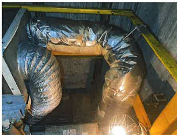
图 14: 轿顶护栏设置不符合现行标准
