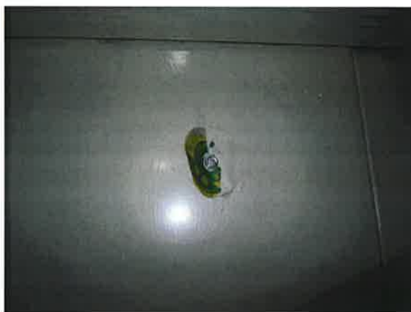
图 16：层门紧急开锁警示标识破损
