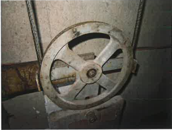
图 20：张紧轮未设置防异物进入的防护罩
