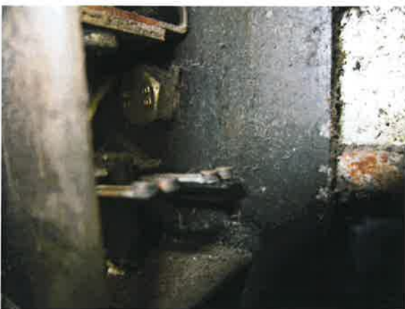
图 17：层门门锁电气开关触点氧化
