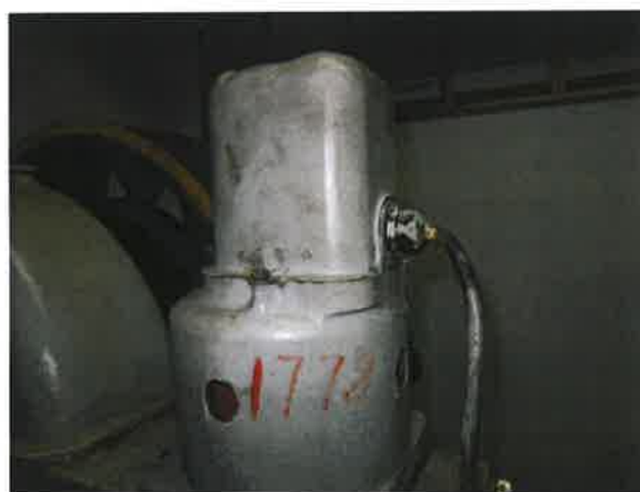
图 11: 制动器仅由一组机械部件（铁芯）组成
