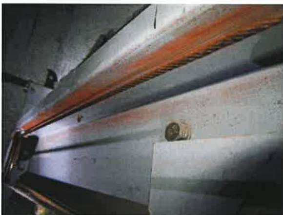
图 15：层门联动钢丝绳锈蚀
