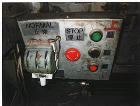
图 8: 轿顶检修和急停开关无防误操作保护
