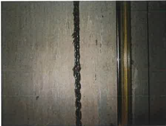
图 19：补偿链消音绳断裂
