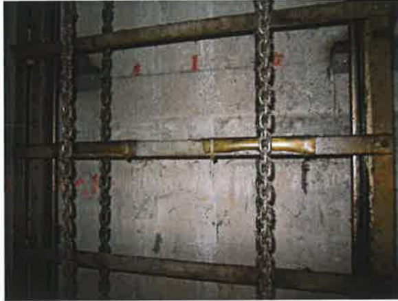
图 22：底坑对重运动区域防护不符合现行标准
