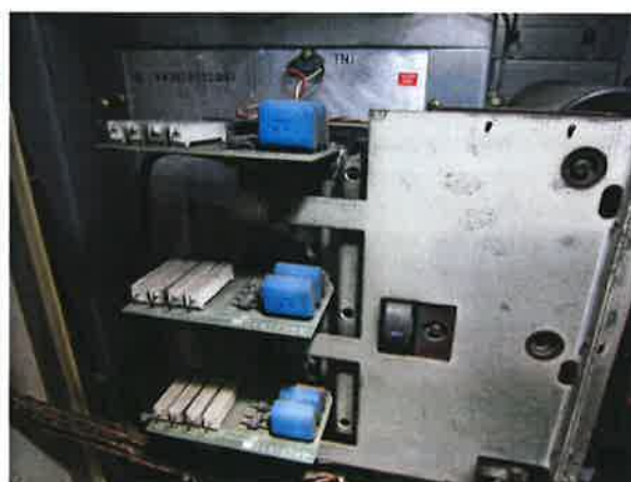
图 4: 调速装置的功率器件老化
