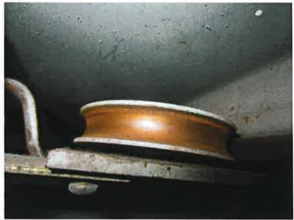
图 14: 轿门门挂轮导向胶老化
