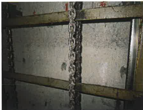
图 20: 底坑对重运动区域防护不符合现行标准
