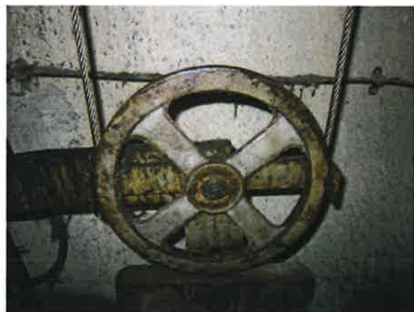
图 18: 张紧轮未设置防异物进入的防护罩
