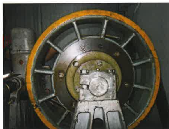
图 12：曳引轮未设置防止异物进入的防护装置
