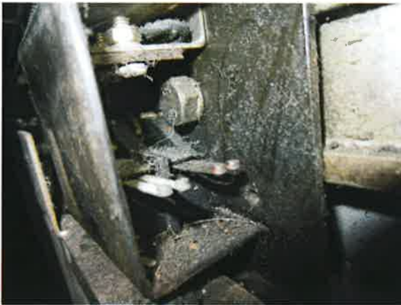
图 15: 层门门锁电气开关触点氧化
