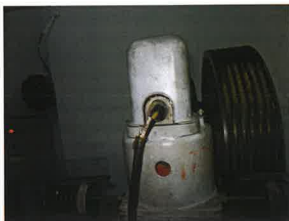
图 10：制动器仅由一组机械部件（铁芯）组成
