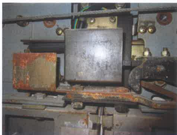
图 32：无门锁短接保护功能
