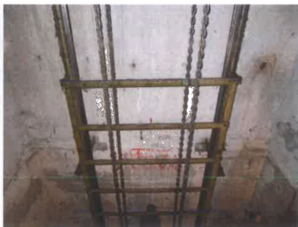
图 34：底坑对重运动区域防护不符合现行标准
