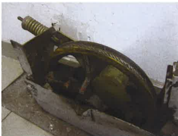
图 28: 限速器无防止异物进入的防护装置
