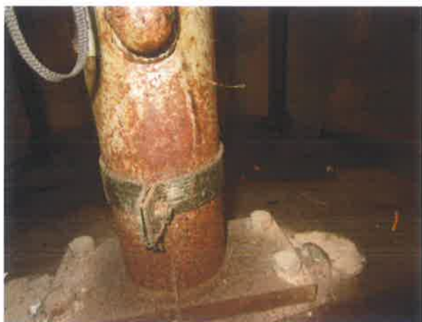
图 31：轿厢缓冲器缸体锈蚀
