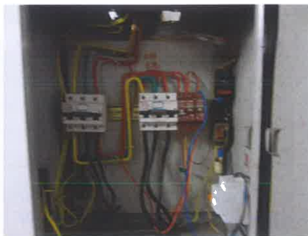
图 10：主开关无防误操作保护
