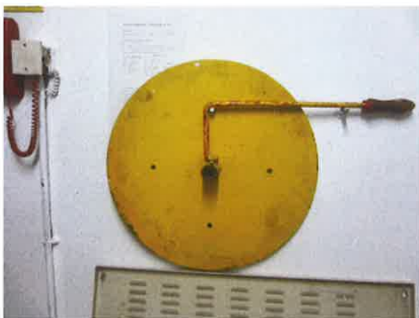
图 13: 可拆卸盘车手轮无相应电气开关
