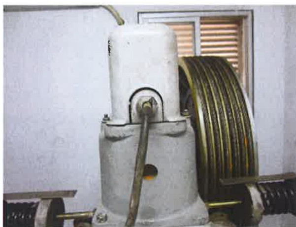
图 16: 制动器仅由一组机械部件（铁芯）组成
