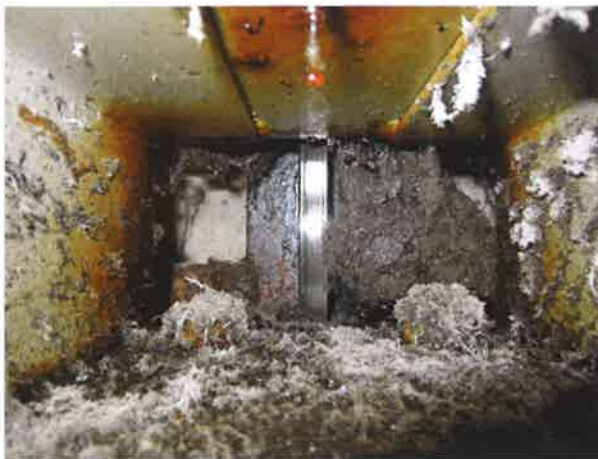
图 30: 安全钳有油泥异物
