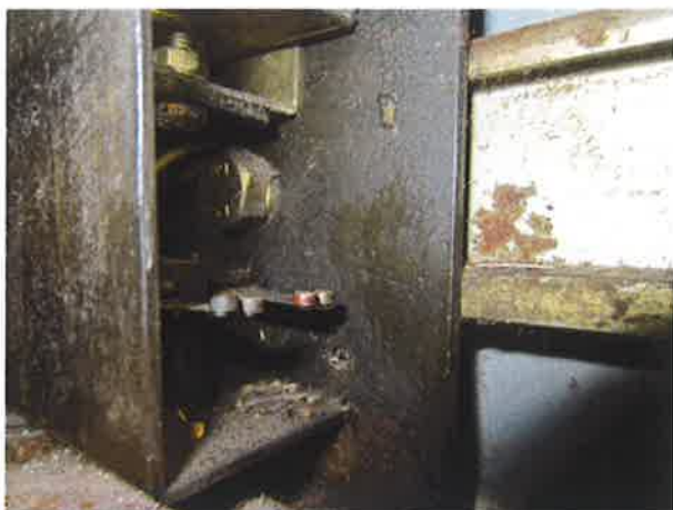
图 25: 层门门锁电气开关触点氧化
