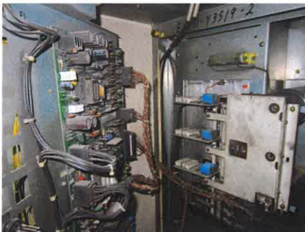
图 5：调速装置老化且有积尘积碳
