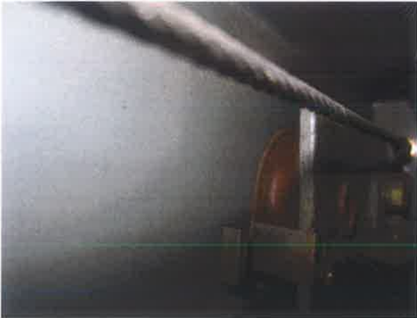
图 21：层门门挂轮胶圈老化
