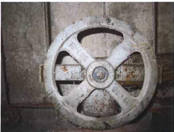
图 29: 张紧轮无防止异物进入的防护装置
