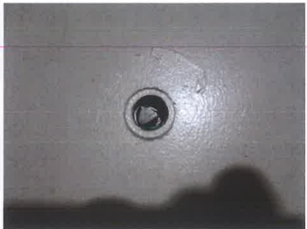
图 24：层门紧急开锁警示标识缺失
