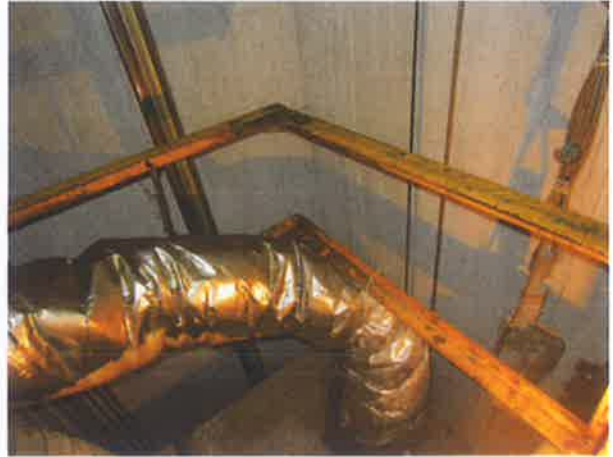
图 20：轿顶护栏设置不符合现行标准
