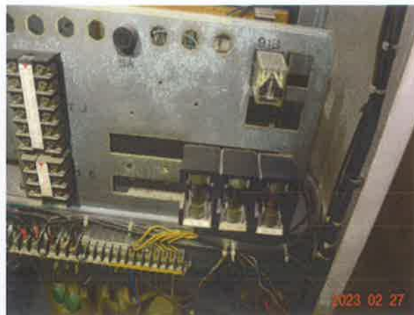
图 8: 电气设备防护罩壳防护等级低于 IP2X
