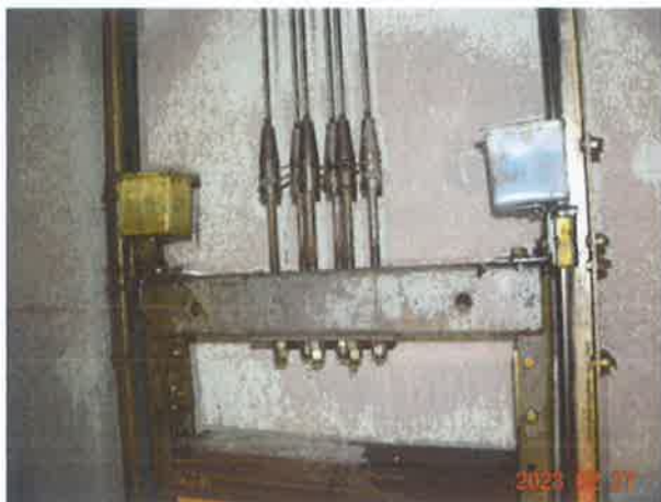
图 19：绳头组合无弹簧缓冲装置
