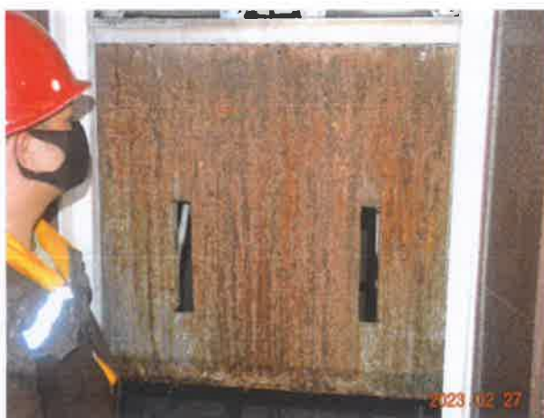
图 23：轿厢护脚板金属部件锈蚀
