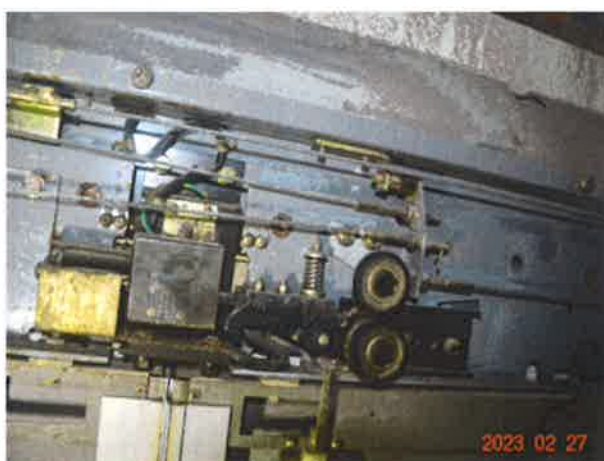
图 18：人为短接门锁电梯仍能再次启动
