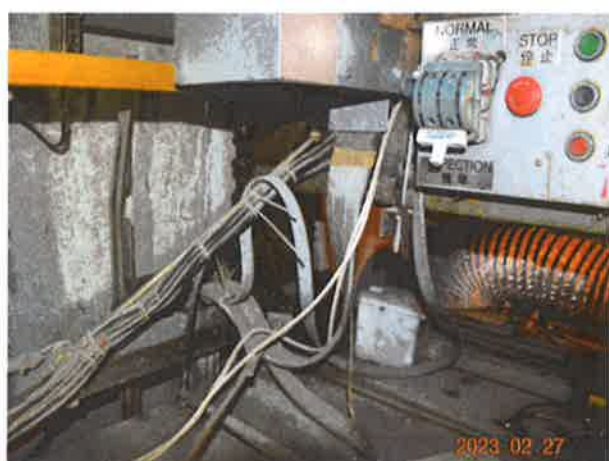
图 15：轿顶检修急停装置无防误操作保护
