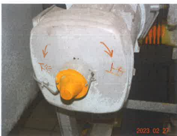
图 11: 可拆卸盘车手轮未设置电气安全装置
