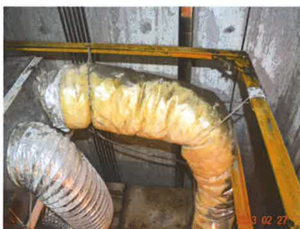
图 16：轿顶护栏设置不符合现行标准要求
