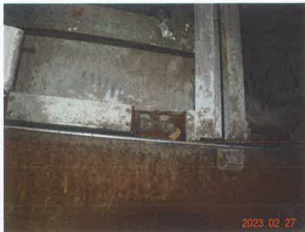
图 20：部分层门门滑块锈蚀磨损
