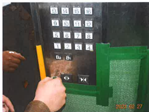
图 4: 轿厢操作装置部分按钮存在动作不良
