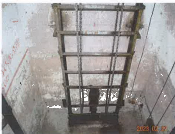
图 21：底坑对重运动区域防护不符合新规范
