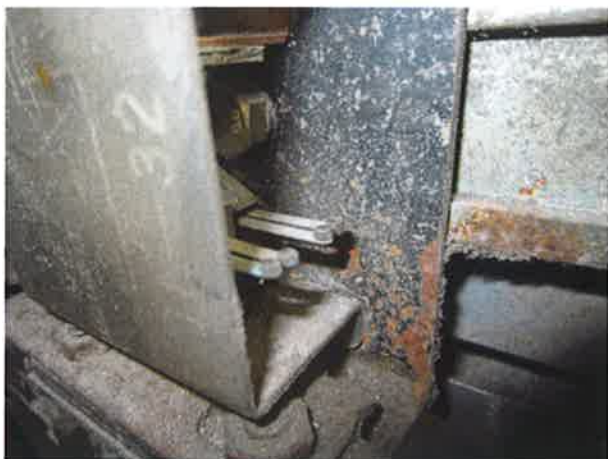
图 25: 层门门锁电气开关触点氧化
