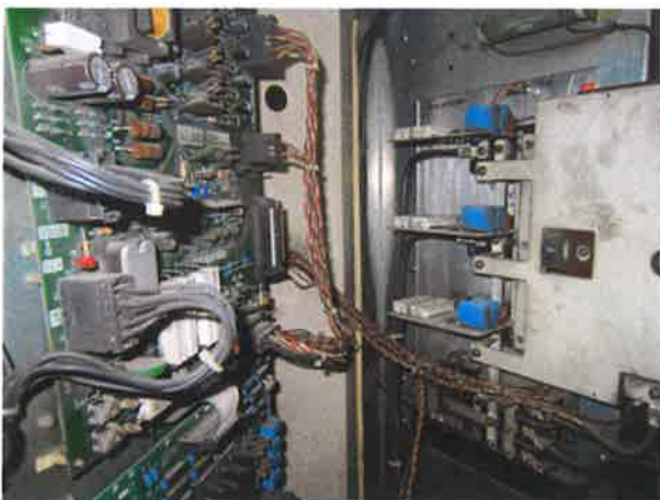
图 5: 调速装置老化且有积尘积碳
