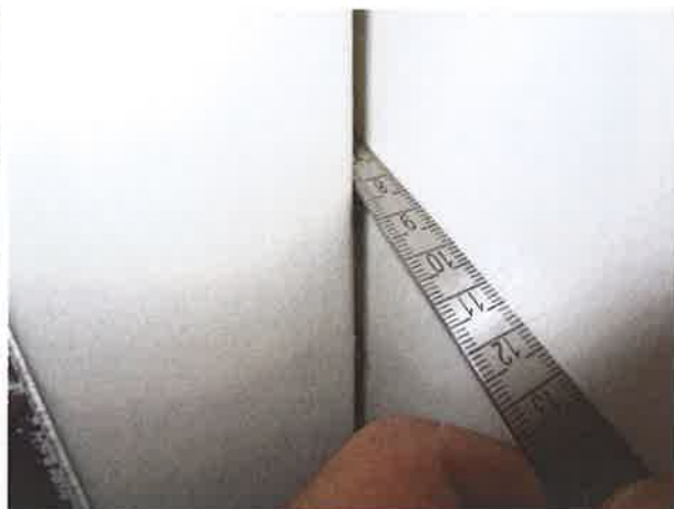
图 26: 门扇与立柱间隙大于 6mm
