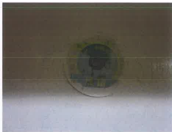
图 24：层门紧急开锁警示标识破损
