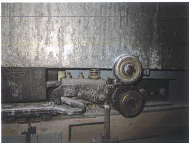
图 31: 无门锁短接保护功能
