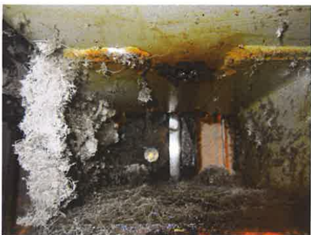
图 30: 安全钳有油泥异物
