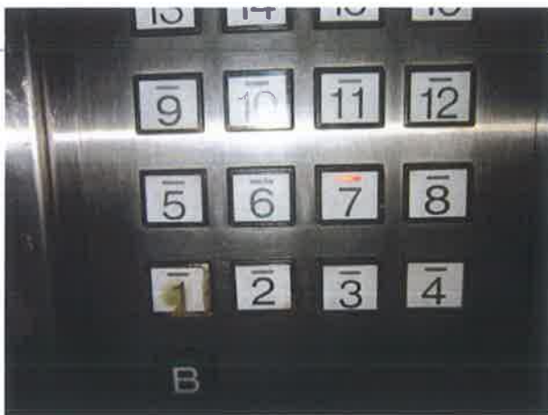
图 7：轿厢部分召唤按钮动作不良
