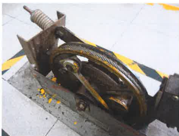
图 28: 限速器无防止异物进入的防护装置
