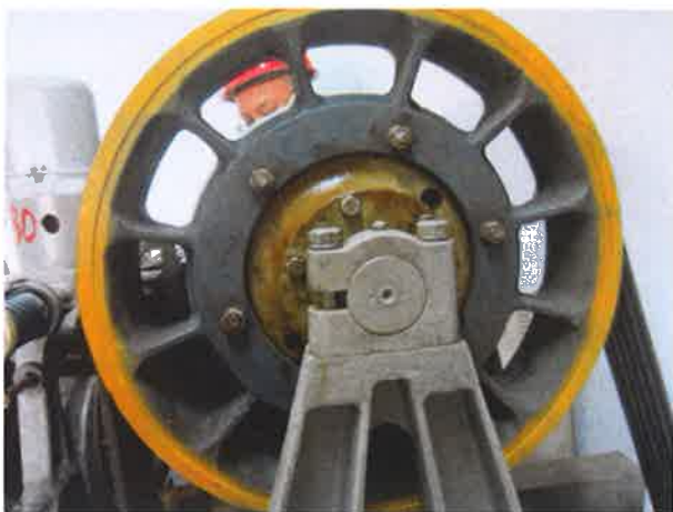
图 18：曳引轮未设置防止异物进入的防护装置
