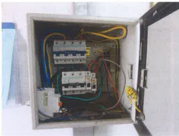
图 9：主开关无防误操作保护
