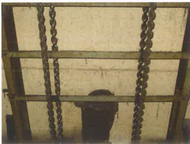
图 33: 底坑对重运动区域防护不符合现行标准
