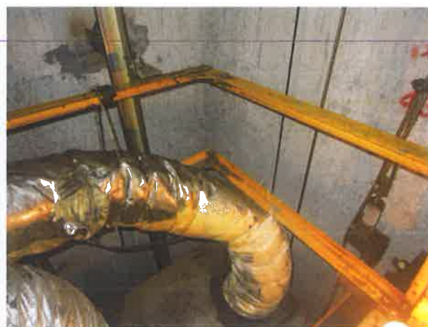
图 20：轿顶护栏设置不符合现行标准
