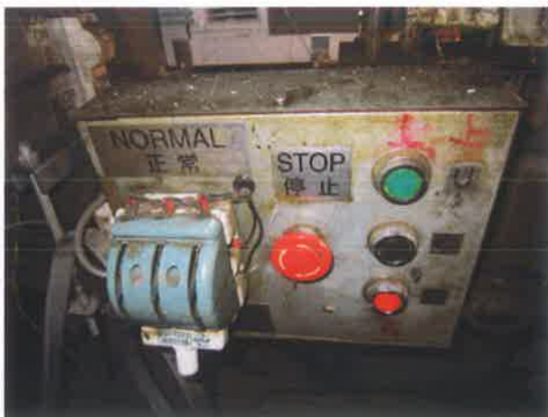
图 11：轿顶检修和急停开关无防误操作保护
