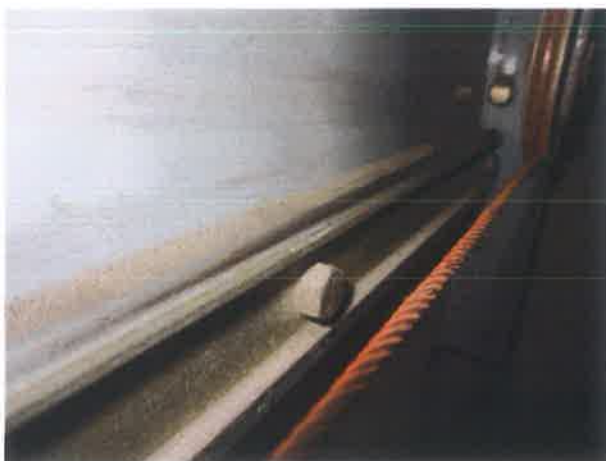
图 23：层门门头钢丝绳锈蚀
