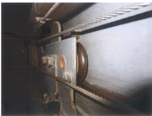
图 21：层门门挂轮胶圈老化
